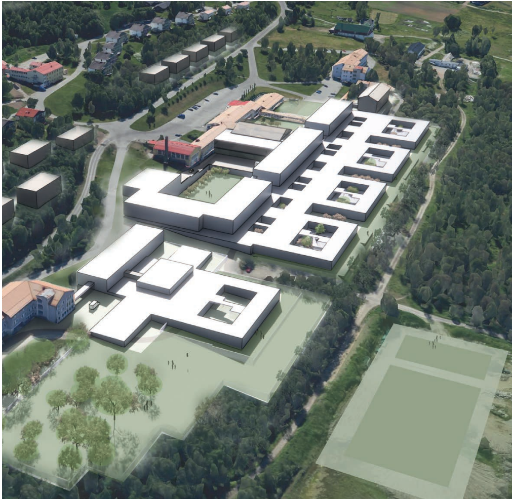
Åsgård Å3 mot nord
