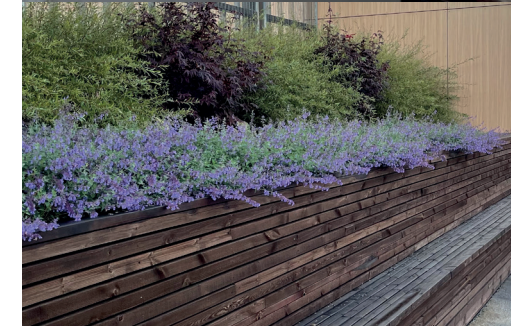
Takhage/takterrasse, Tønsberg psykiatri
